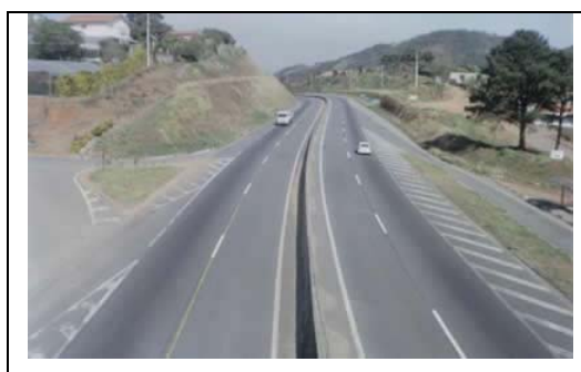
Figura 33 – Trecho da rodovia BR-381, ilustrando condição de pavimentação
