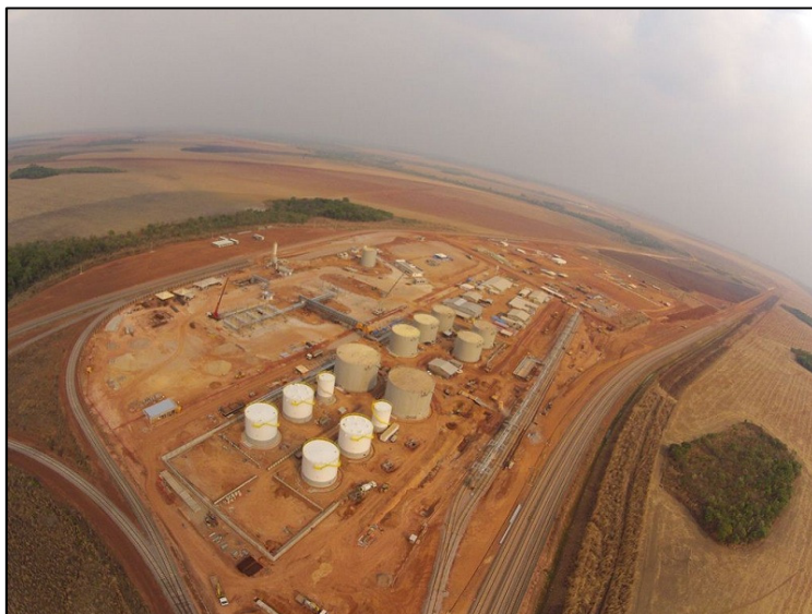
Figura 11: Terminal Multimodal de Colinas
