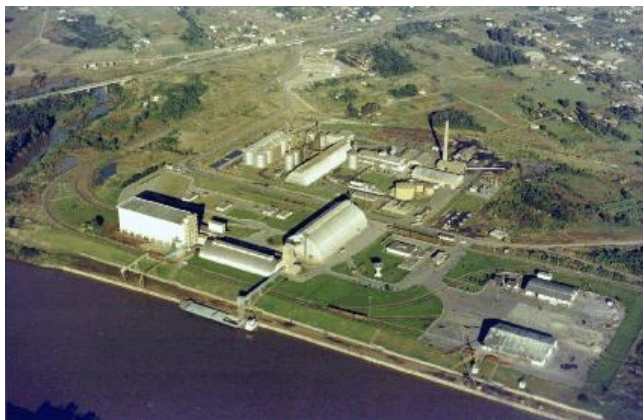
Fonte: Administração Porto Fluvia de Estrela Figura 21: Porto de Estrela
