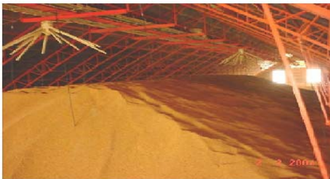
Figura 1: Interior de “armazém graneleiro” no Brasil: menor compartimentação. Fonte: Quirino (2004)
